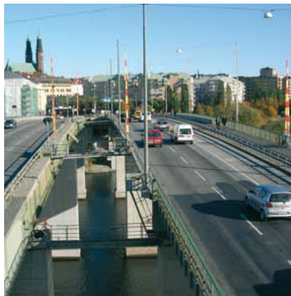
Liljeholmsbron i centrala Stockholm är en viktig del av stadens vägnät. Den äldsta delen av de två broarna är från 1928 och den andra bron från 1954.
