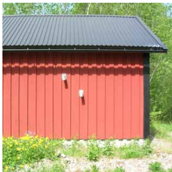
Utanför tryckstegringsstationen leds våtluft ut och man tar in regenereringsluft.
