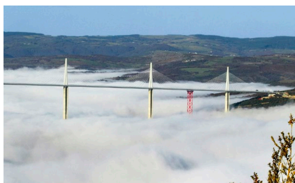
Millaubron är 2 460 meter lång och 32 meter bred. Höjd på högsta stället är 343 meter, vilket är 20 meter högre än Eiffeltornet
